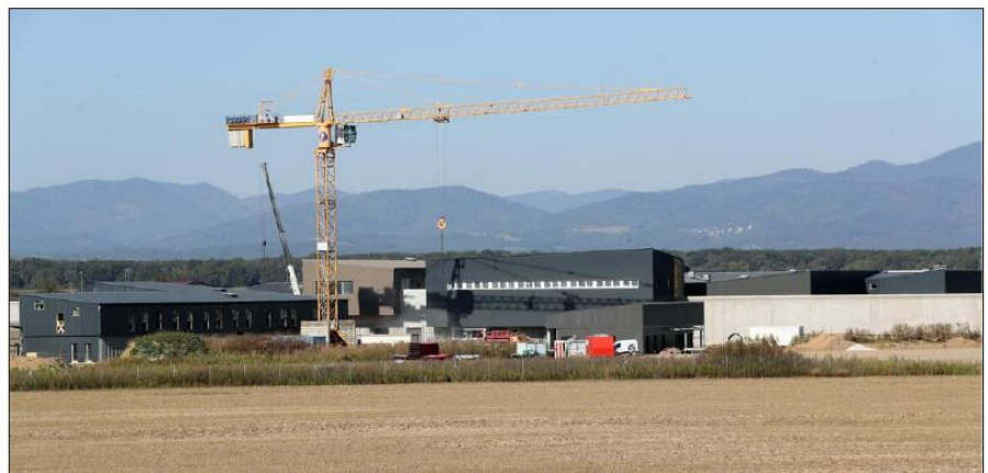
Le chantier du centre pénitentiaire de Lutterbach, photographié en septembre dernier. Photo L'Alsace/Thierry GACHON
