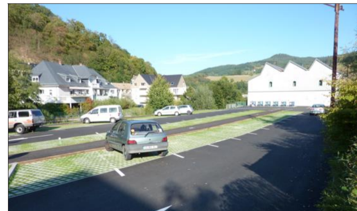
Réalisation 2015 : l'aménagement du parking des écoles, fonctionnel, esthétique et écologique puisque les eaux de pluies sont drainées dans le sol et non canalisées dans la rivière. Au fond, les containers pour la récupération du verre et papier.
