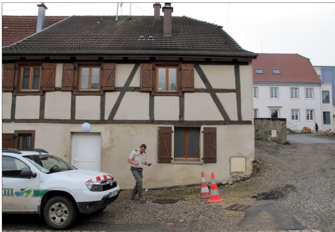
Les nouveaux locaux de la Brigade verte (au premier plan), juste à côté de l'ancien presbytère (au fond à droite) qui a été transformé en mairie. Les services municipaux devraient y emménager d'ici un ou deux mois. Photos L'Alsace/S.Sp.
