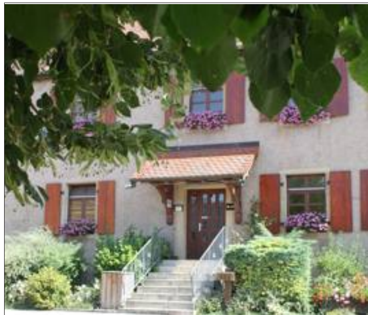
Le Manoir accueille une grande salle au rez-de-chaussée et les locaux de la MJC au sous-sol, ainsi que la mairie au premier étage.
